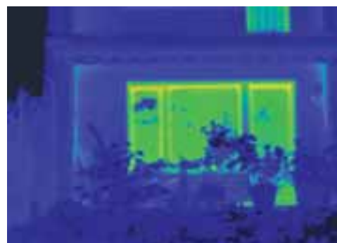
Nach dem sorgfältigen Einbau neuer Corona CT 70-Fenster beweist die Thermografie den hohen energetischen Nutzen der Investition. Der ursprüngliche Energieverlust wird nahezu vollständig vermieden.
